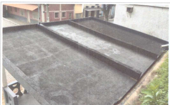
IMPERMEABILIZAÇÃO DA LAJE DO CORETO
