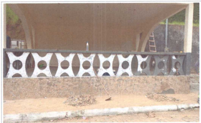
REMOÇÃO MANUAL DE EMBOÇO DETERIORADO
