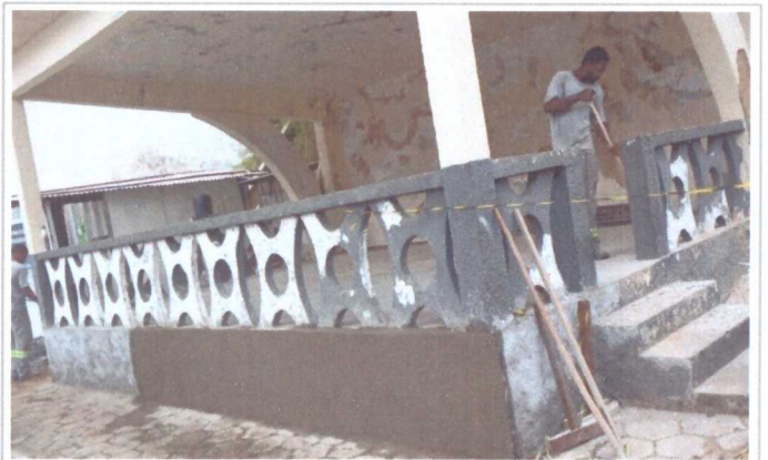
EXECUÇÃO DE NOVO EMBOÇO
