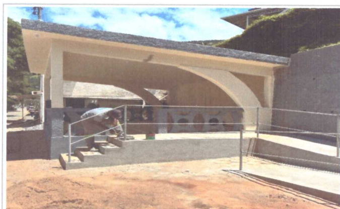
PINTURA DO GUARDA-CORPO
