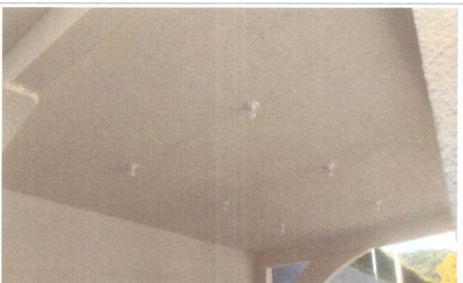
APLICAÇÃO DE TEXTURA E PINTURA DO CORETO
