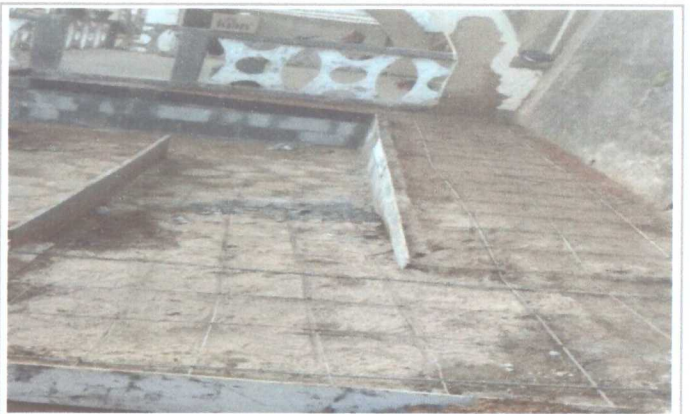
EXECUÇÃO DA ESCADA E RAMPA
