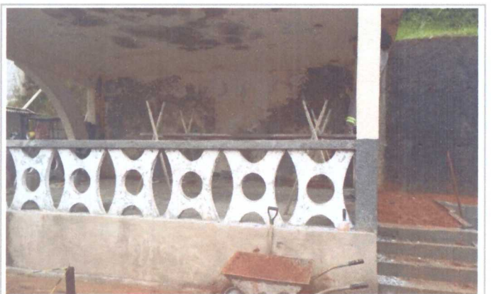
RASPAGEM MANUAL DE CAMADA DE PINTURA EXISTENTE
