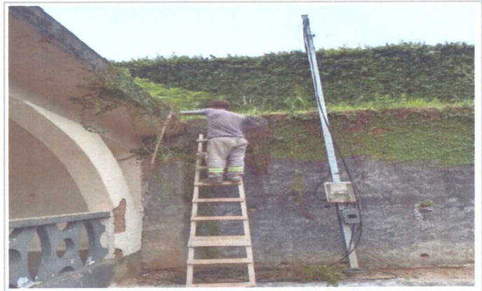
LIMPEZA E RETIRADA DE VEGETAÇÃO INVASIVA
