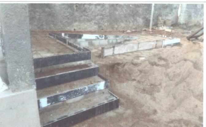
EXECUÇÃO DA ESCADA E RAMPA
