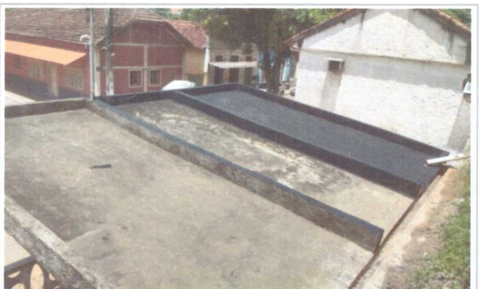
IMPERMEABILIZAÇÃO DA LAJE DO CORETO
