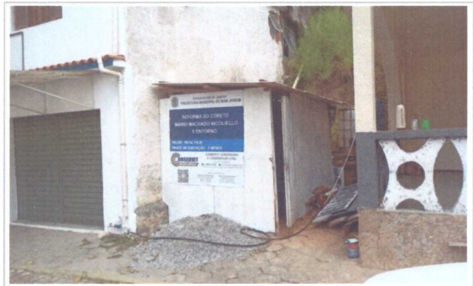
BARRACÃO DE OBRA
