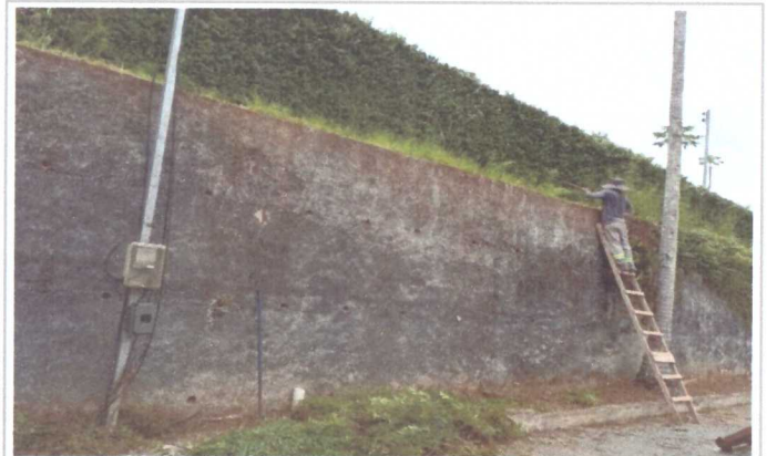
LIMPEZA E RETIRADA DE VEGETAÇÃO INVASIVA
