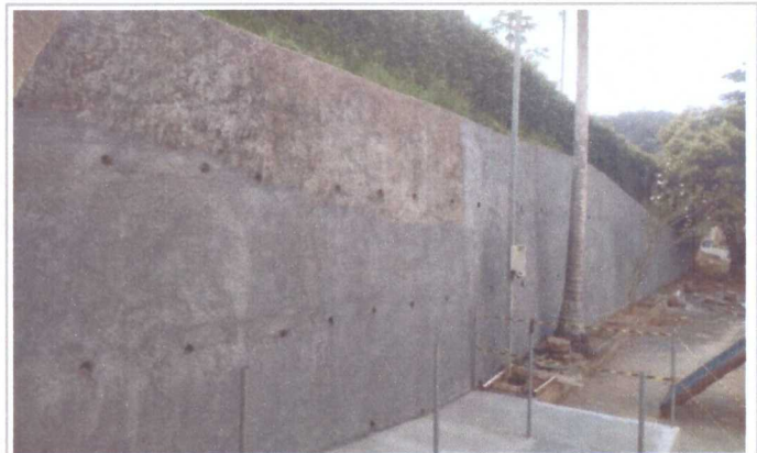
PINTURA DO MURO DE CONTENÇÃO
