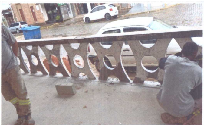
RASPAGEM MANUAL DE CAMADA DE PINTURA EXISTENTE
