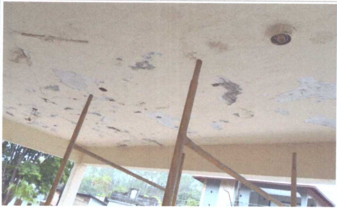
RASPAGEM MANUAL DE CAMADA DE PINTURA EXISTENTE
