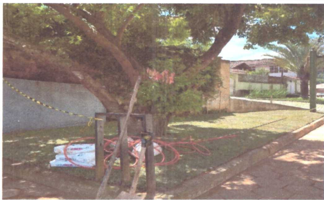
GRAMA COLOCADA NO CANTEIRO
