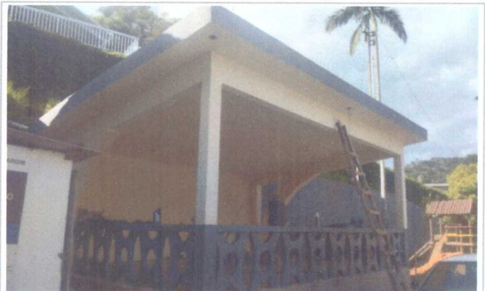
APLICAÇÃO DE TEXTURA E PINTURA DO CORETO
