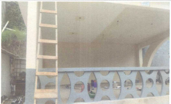
APLICAÇÃO DE TEXTURA E PINTURA DO CORETO
