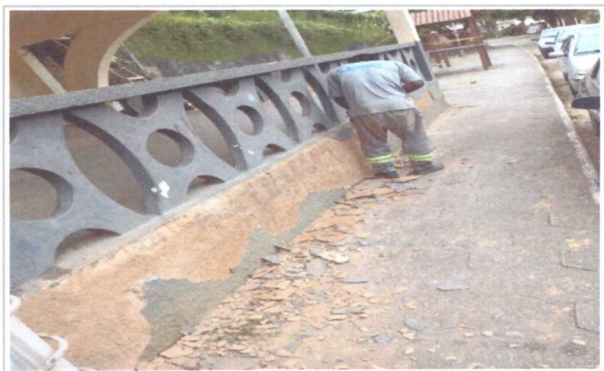
REMOÇÃO MANUAL DE EMBOÇO DETERIORADO
