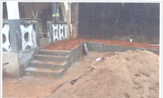
EXECUÇÃO DA ESCADA E RAMPA
