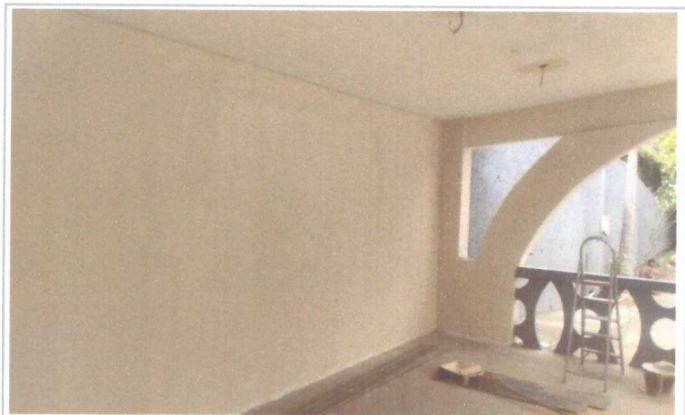
APLICAÇÃO DE TEXTURA E PINTURA DO CORETO
