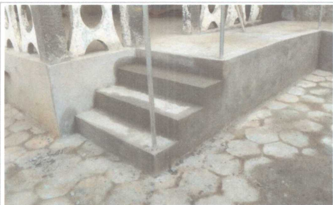
EXECUÇÃO DE ACABAMENTO DA ESCADA E RAMPA
