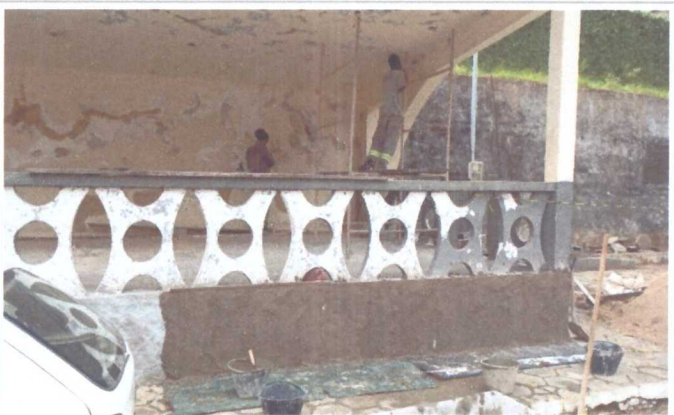
EXECUÇÃO DE NOVO EMBOÇO
