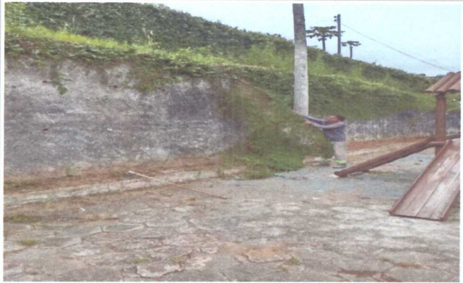
LIMPEZA E RETIRADA DE VEGETAÇÃO INVASIVA
