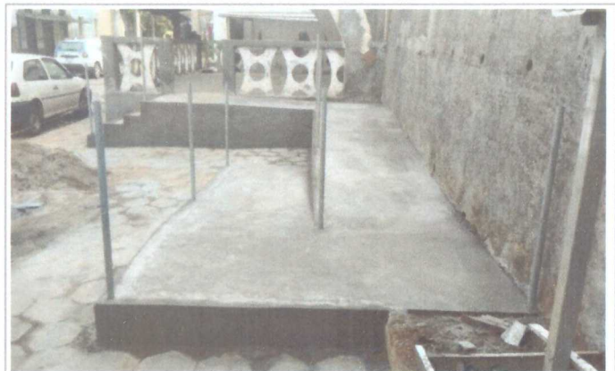
EXECUÇÃO DE ACABAMENTO DA ESCADA E RAMPA
