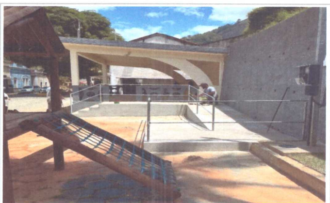
PINTURA DO GUARDA-CORPO
