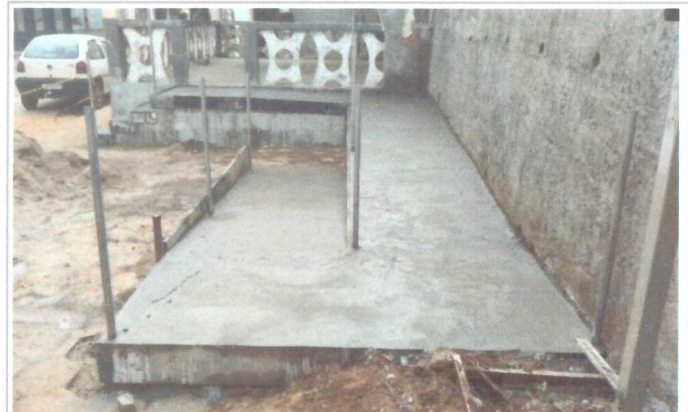
CONCRETAGEM DA ESCADA E RAMPA / ASSENTAMENTO DO MONTANTE DO GUARDA-CORPO
