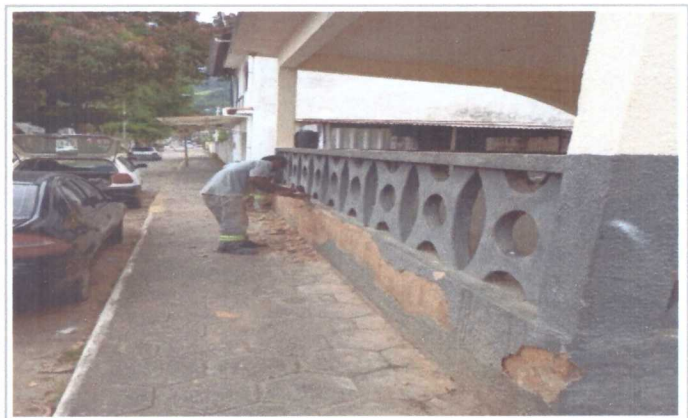
REMOÇÃO MANUAL DE EMBOÇO DETERIORADO
