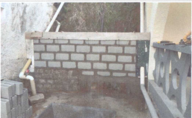
EXECUÇÃO DA MURETA AO LADO CORETO
