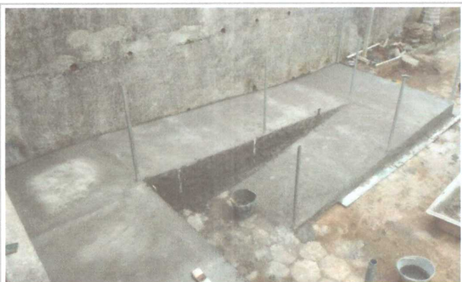
EXECUÇÃO DE ACABAMENTO DA ESCADA E RAMPA
